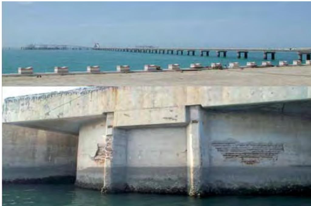
*Les dégradations causées par l'environnement marin sur les ouvrages en béton sont souvent très sévères.*
