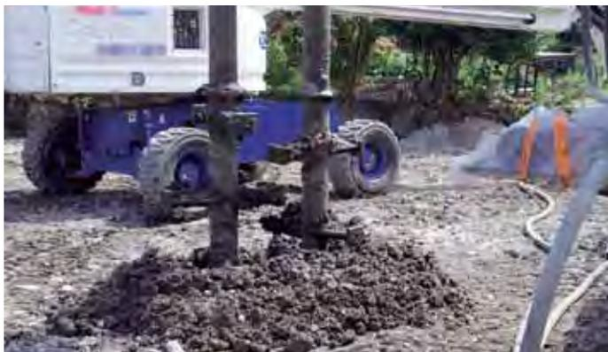
La technique du Deep Soil Mixing consiste à mélanger le sol en place avec du coulis de ciment, par des moyens mécaniques de type pales fixes ou mobiles.
